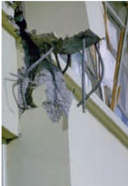
Effondrements de bâtiment dû au non-respect du principe « poteaux forts - poutres faibles ». La résistance ultime des poutres-allèges en béton armé était supérieure à celle des poteaux. En outre, on peut observer l'effet de poteau court (séisme de Tokachi-Oki, Japon 1968 et d'Izmir, Turquie 1999)
