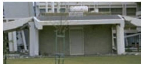
**Fig. 15 - Rupture de porte-à-faux, séisme de San Fernando, Californie 1971**
