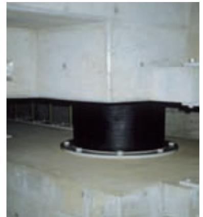
**Fig. 30 - Exemple d'isolateur sous un immeuble**
