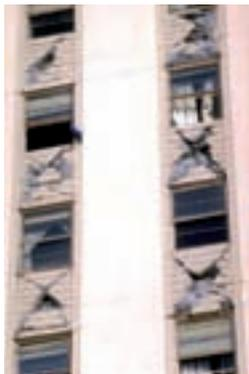
Fig. 86 - Rupture de poutres-allèges entre voiles couplés. Cet effet de fusible a préservé les voiles porteurs, mais si les linteaux avaient été armés pour avoir un comportement ductile, les dommages auraient pu être limités. Immeuble McKinley, séisme d'Alaska, 1964.
