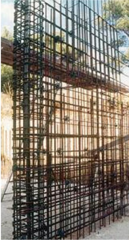
**Fig. 101 - Exemple de l'armature d'un mur ductile**
