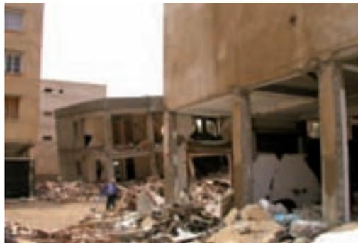
**Fig. 51 - L'éclatement de remplissages transforme les rez-de-chaussée en niveaux souples, dont l'écrasement est fréquent, séisme de Boumerdès, Algérie 2008**
