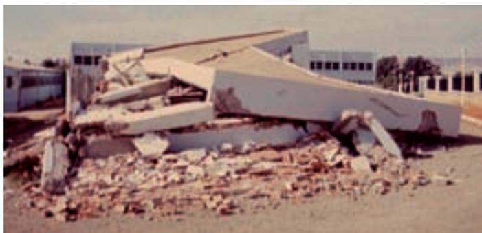
**Fig. 17 - Effondrement dû à la torsion, El Asnam 1980**
