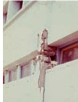
**Fig. 37 - L'effet de poteau court dû à la présence d'allèges en maçonnerie dans la structure principale en portiques, séisme d'El Asnam, Algérie 1980**
