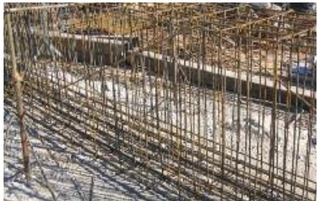
Fig. 93 - Exemples d'armature de confinement des poutres et des poteaux
