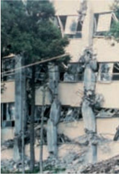
nécessitant des traverses de portiques hautes est donc déconseillée. Si on souhaite conserver l'architecture de poutres-allèges en zone sismique, le contreventement du bâtiment doit être assuré par des voiles et non par effet de portique.
