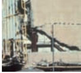
**Fig. 49 - Dommages aux voiles en béton facilement réparables, occasionnés par le séisme de Kôbé, Japon 1995 (6300 morts). L'immeuble est situé dans la zone la plus touchée par le tremblement de terre**
