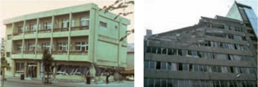
Fig. 59 - Dommages sismiques dus à la torsion d'ensemble, séismes de Tokachi-Oki, Japon 1968 et du Mexique, 1985
