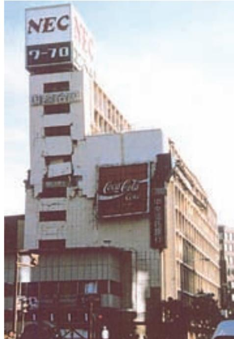
Fig. 21 - Dommages dus à des oscillations différentielles en plan et en élévation, séisme de Kobé, Japon 1995
