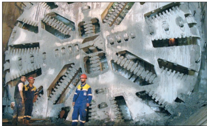
Figure 3 - Roue de coupe du tunnelier mixte / Dual mode TBM cutting wheel.
