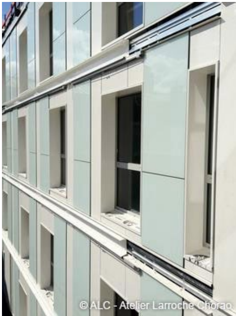
Ouvertures (fenêtres) sur la façade
