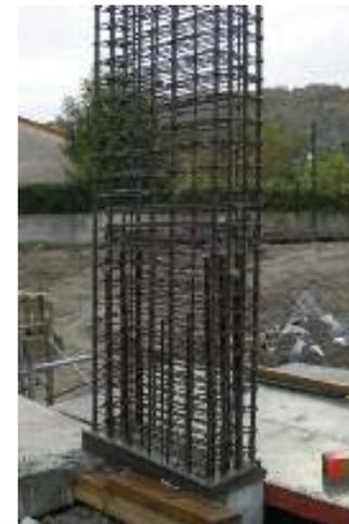
Crochet d'ancrage d'armatures longitudinales
