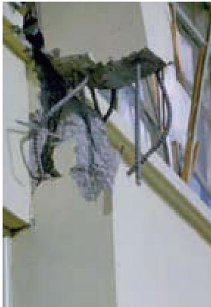
Effondrements de bâtiment dû au non-respect du principe « poteaux forts - poutres faibles ». La résistance ultime des poutres-allèges en béton armé était supérieure à celle des poteaux. En outre, on peut observer l'effet de poteau court (séisme de Tokachi-Oki, Japon 1968 et d'Izmir, Turquie 1999)
