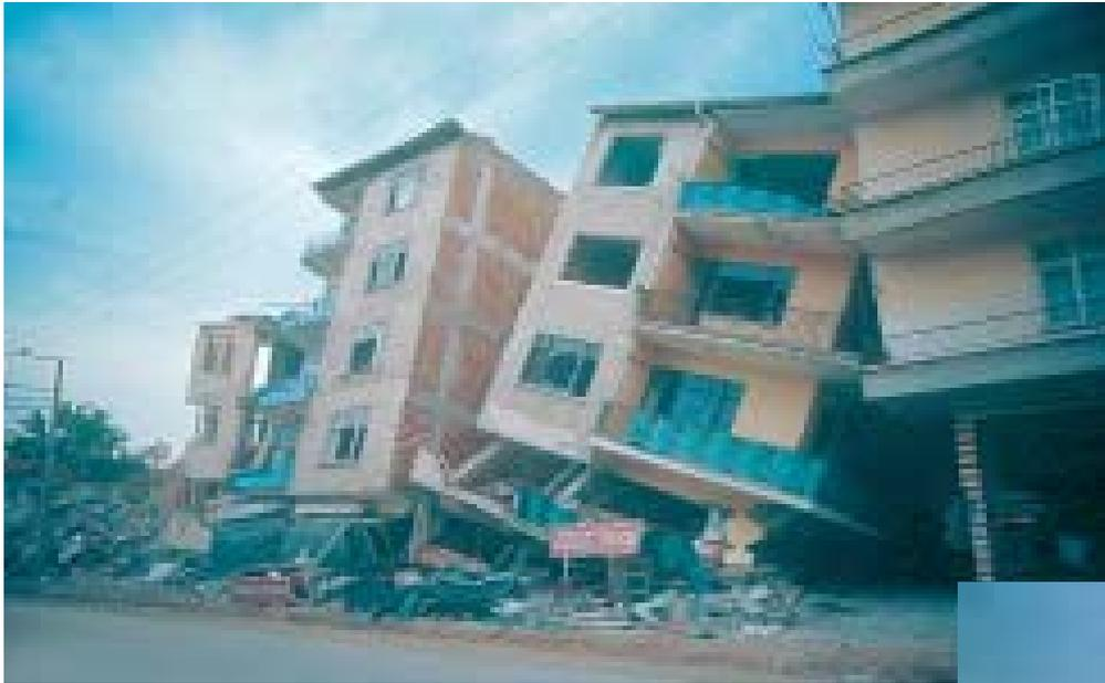
3- Eviter les rez-de-chaussée flexibles!
