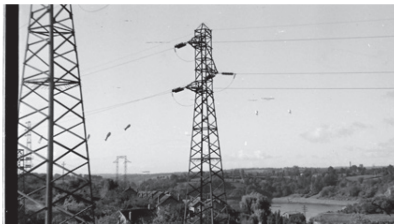
8a. Ballons de barrage allemands reliés au sol par des câbles en acier pour empêcher le vol rasant des avions alliés au-dessus du barrage d'Éguzon (archives Michel Boyé, photographies Louis Boyé).
