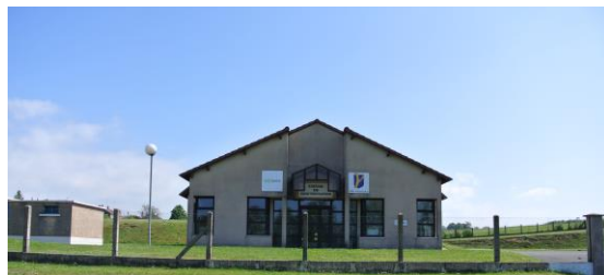
Usine de traitement de l'eau d'Issoudun
