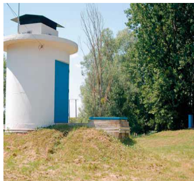
Station de pompage des Chézeaux
