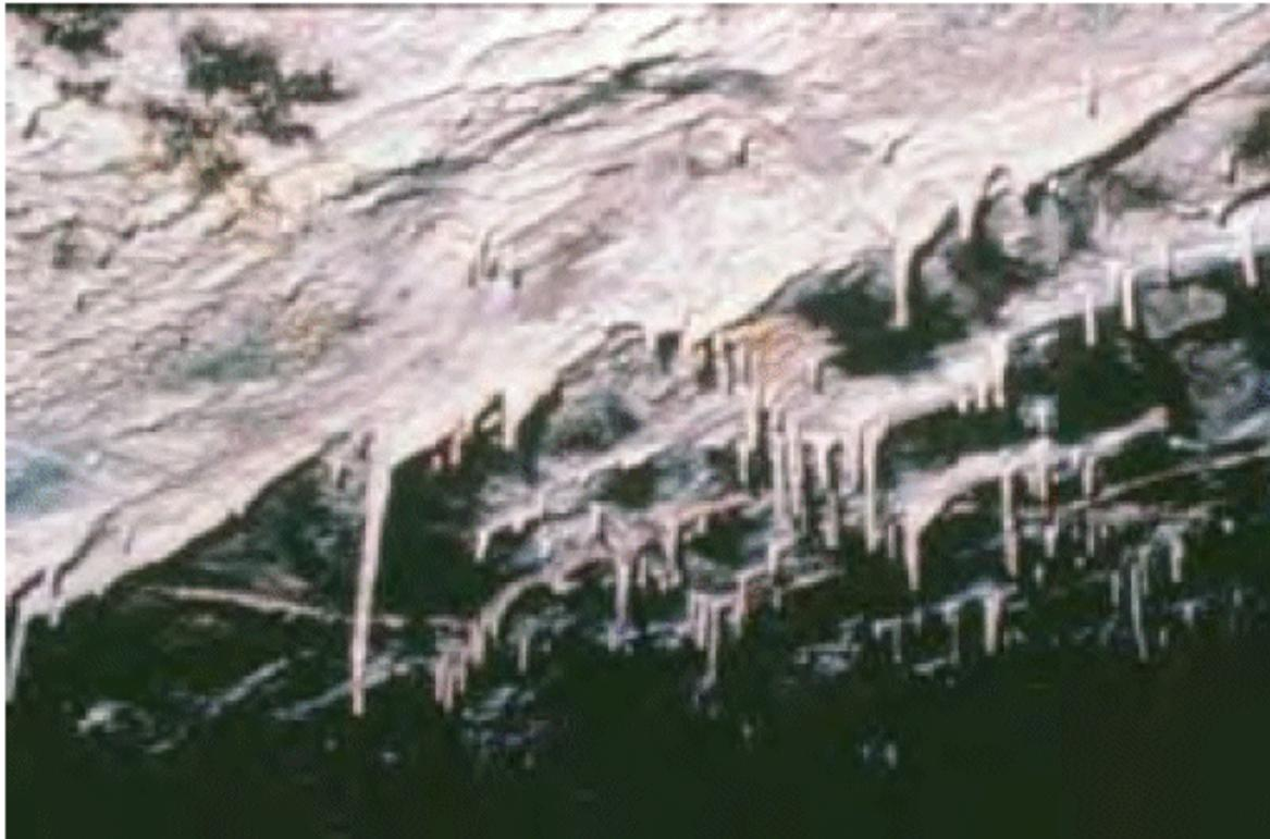
*Photo n° 13 : stalactites actives provenant de la dissolution du mortier des joints entre pierres d'un pont en maçonnerie, par défaut ou absence d'étanchéité favorisant le cheminement de l'eau à travers l'ouvrage – Source : RST*
