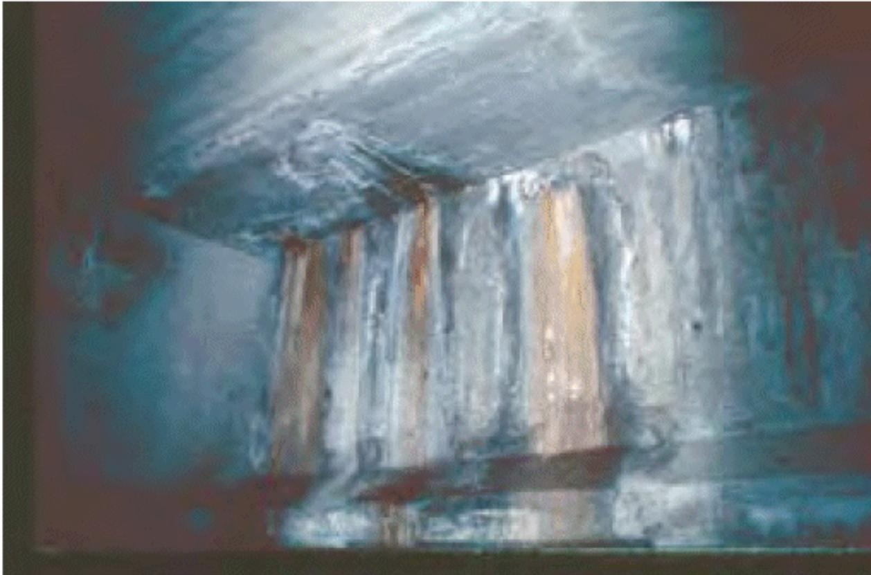
*Photo n° 14 : efflorescences et coulures d'eau de couleur rouille, en extrémité d'une poutre de VIPP, le long de câbles relevés de précontrainte, par défaut d'étanchéité – Source : RST*
