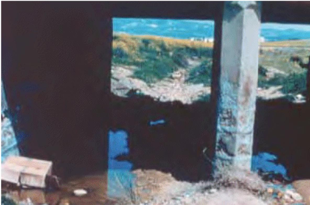
*Photo n° 17 : dégradation des parements et attaque en profondeur du béton en pied de pile et sur le mur de front d'une culée, par défaut de protection contre un environnement particulièrement agressif – Source : RST*
