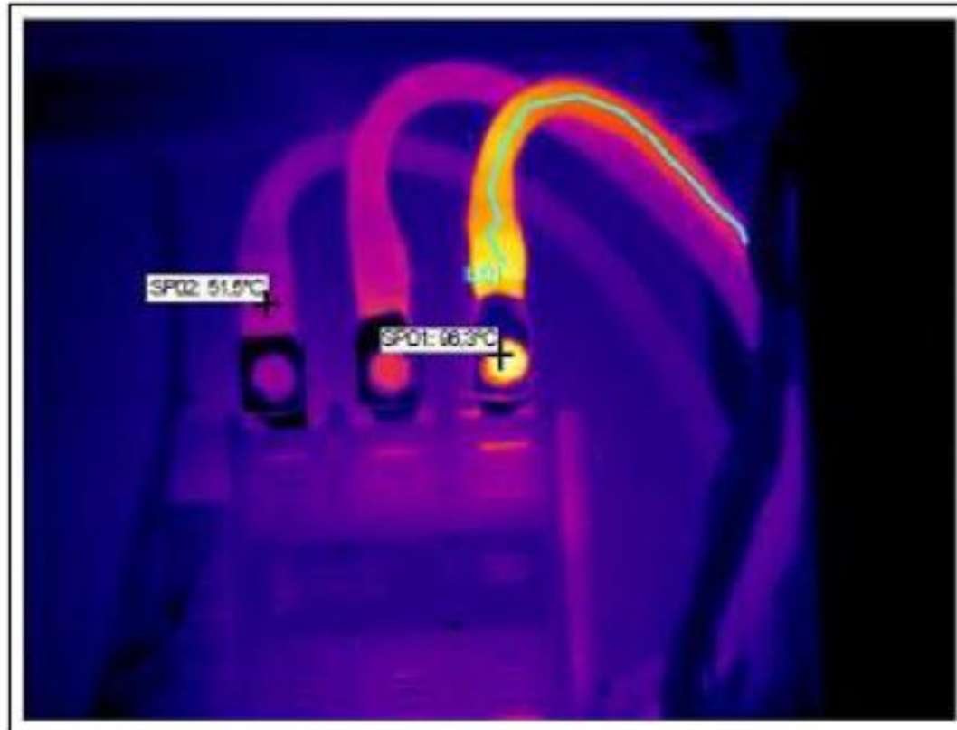
Exemple de défaut électrique de connexion (mauvais serrage)
