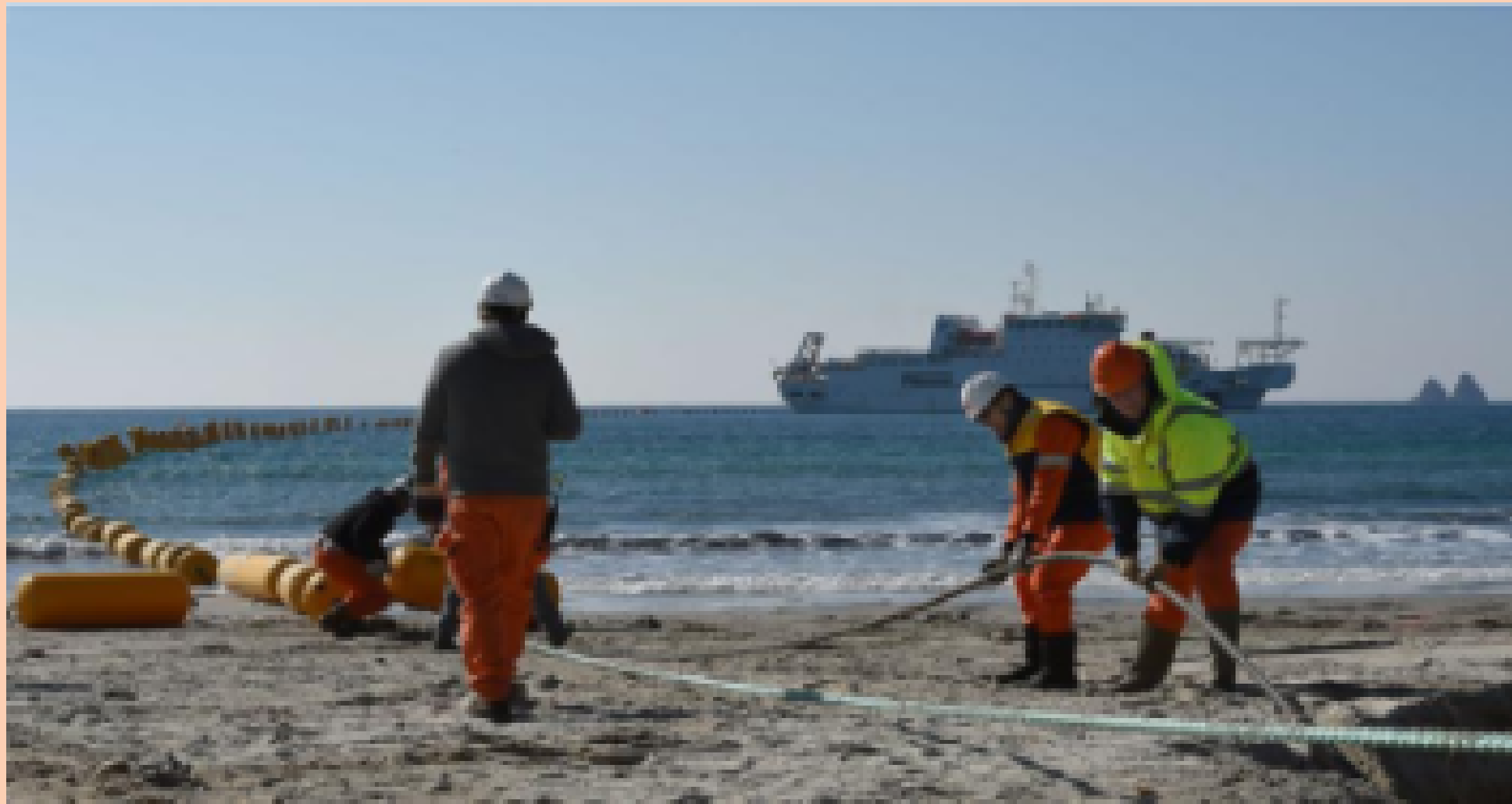
Mise en place d'un câble sous-marin entre l'Europe et l'Afrique
