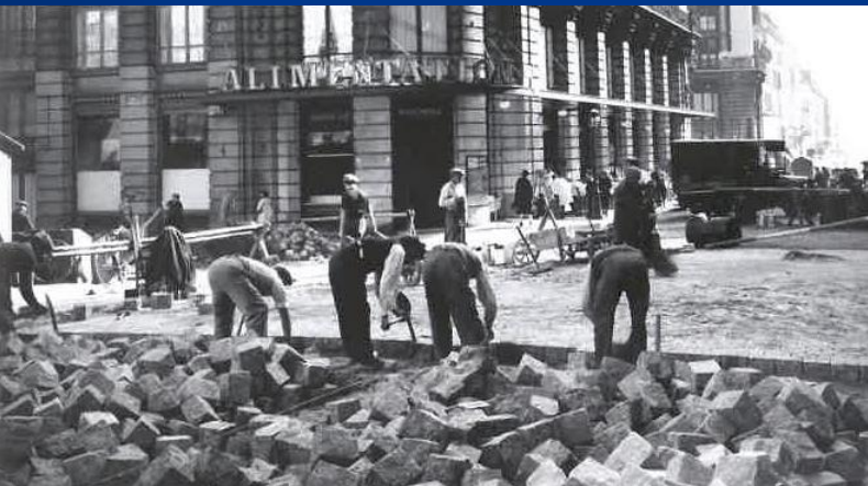
Pavage des avenues de Paris (1930)
