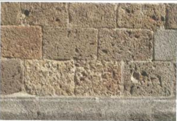
Mur massif en pierre de taille à assise régulière
