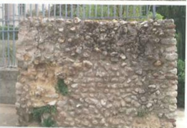
Maçonnerie d'époque romaine à parement en moellons
