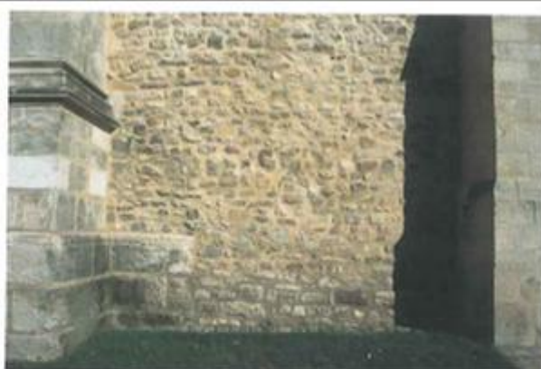
Mur en moellons d'assise irrégulière
