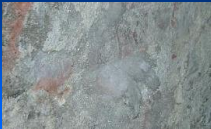
Efflorescence (mur extérieur, Oisterwijk, Pays-bas)
