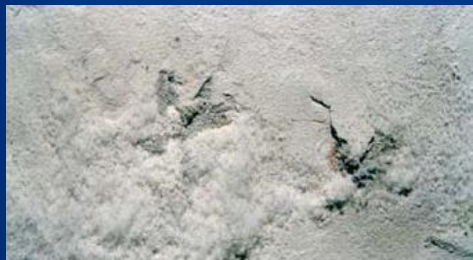
Efflorescence (mur extérieur, Oisterwijk, Pays-bas)
